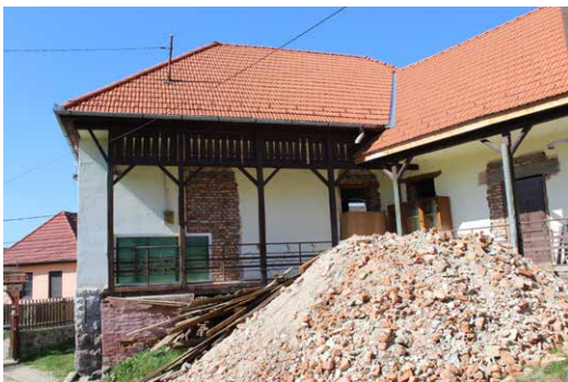
Bild: noch ist es eine Baustelle
